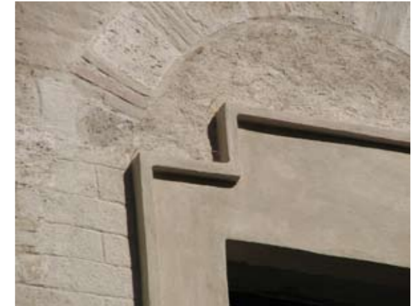
Dattaglio dell'intervento in facciata
