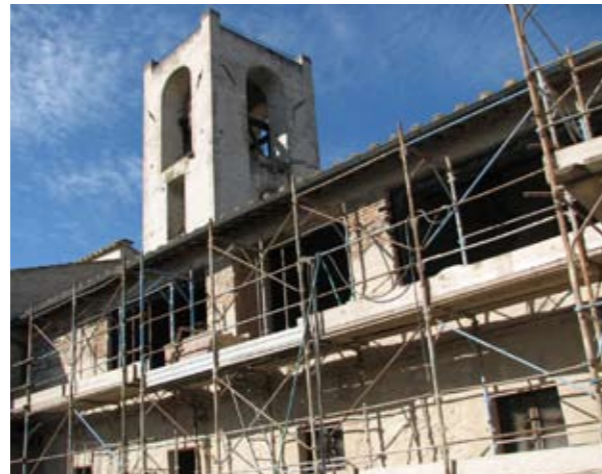
Il ripristino del loggiato al piano sottotetto
