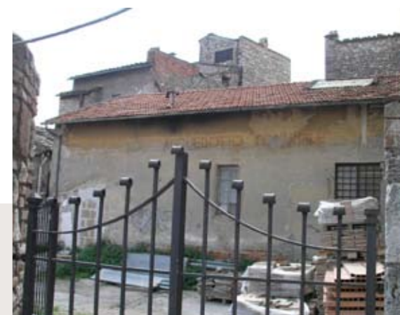
La superfetazione delle officine dell'acquedotto
