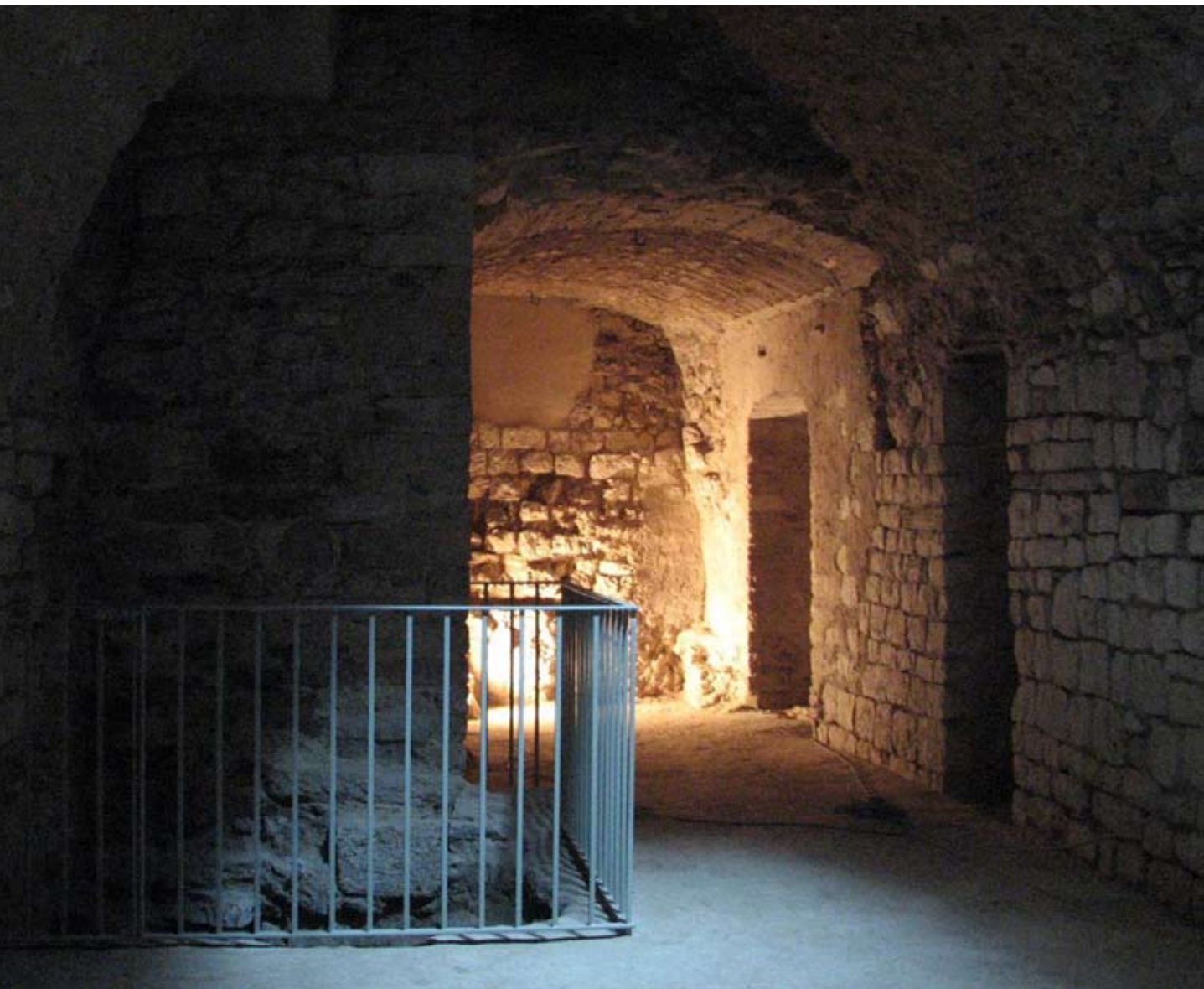
I locali ipogei
