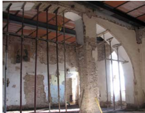
La Sala della Vergine durante i lavori
