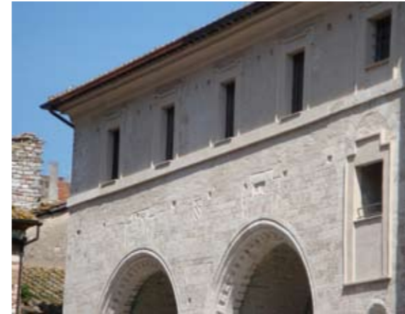
Particolare della facciata principale
